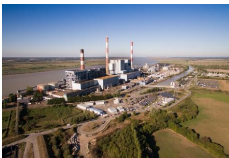
Centrale au charbon à Cordemais
